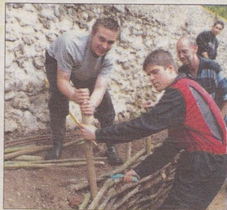
Montigny-le-Gannelon, hier. Matthieu et Vincent (de gauche à droite) consolident les berges du lavoir.
